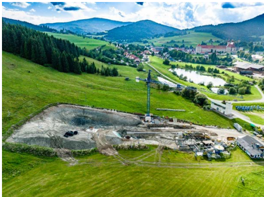
Der aktuelle Baufortschritt an der Talstation. Foto vom 30.08.2022 Foto: Mediadome
