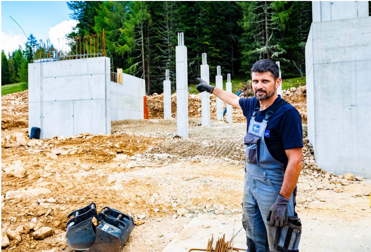
Auf der Grebenzen laufen die Bauarbeiten auf Hochtouren – GF und Bauleiter Bernhard Plank zeigt, wo sich der Ausstieg an der Bergstation befinden wird. Foto: Mediadome
