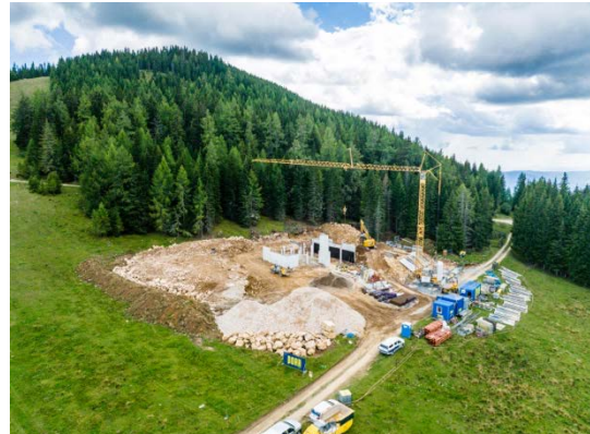
Der aktuelle Baufortschritt an der Bergstation etwa 120 m vom Grebenzenhaus entfernt. Foto vom 30.08.2022 Foto: Mediadome
